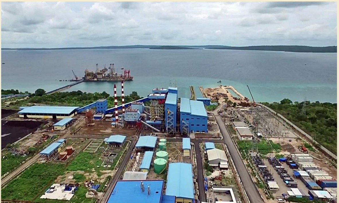
PLTU BOLOK (Pembangkit Listrik dengan kapasitas 73 MW)
