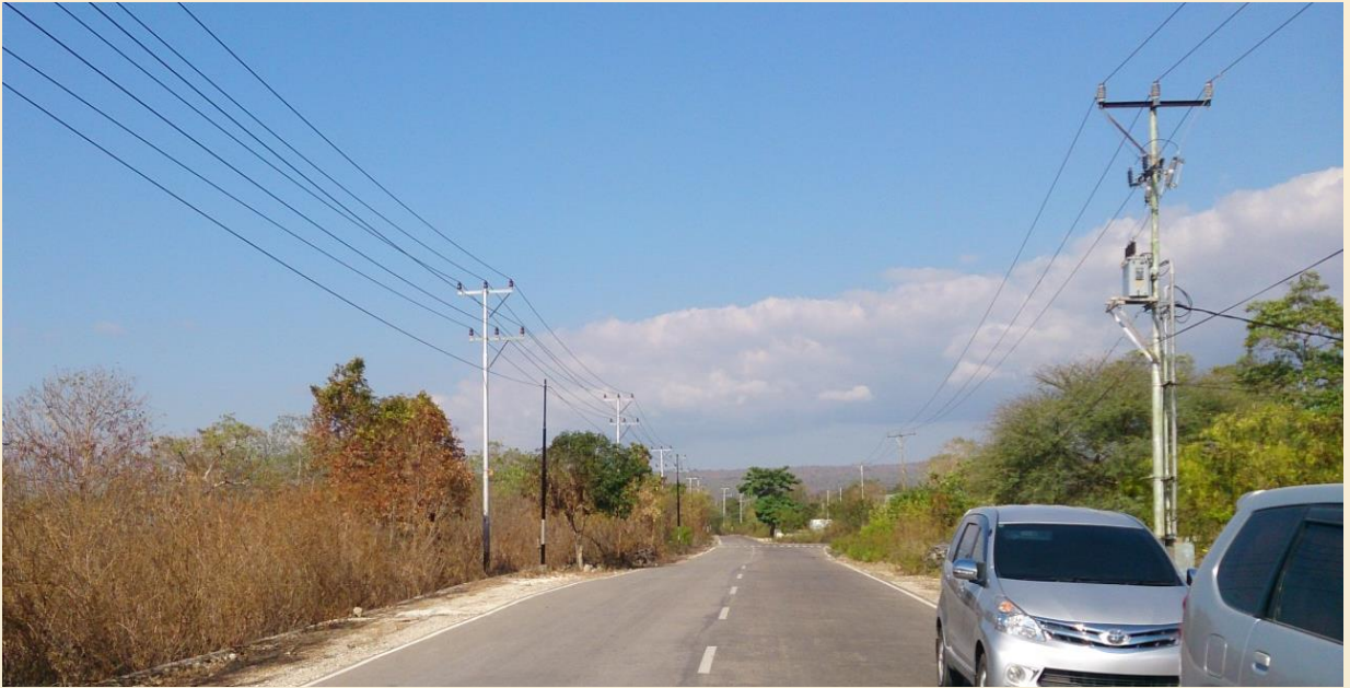
Jaringan Jalan, Listrik, Telepon dan Internet
